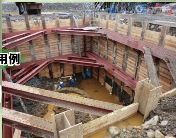
木矢板の使用例2
