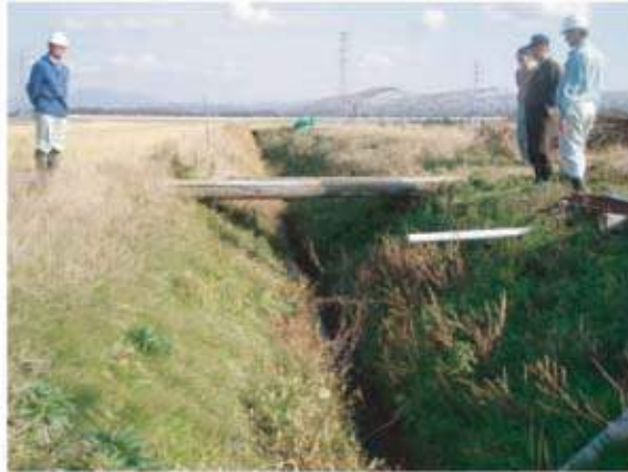
架設前の状況
