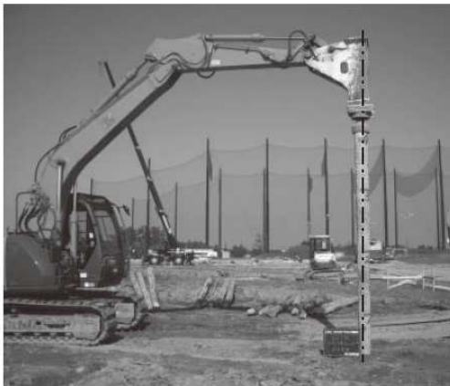
図-4 丸太杭とブレイカの鉛直性が確保された状態
