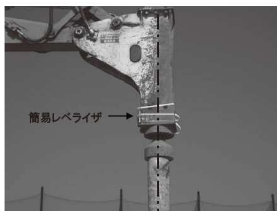
図-9 簡易レベライザ装着後の鉛直補正
